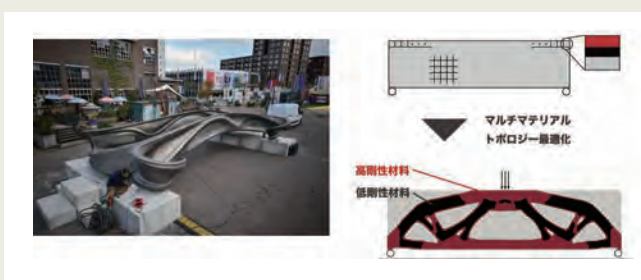
図1 左) 3Dプリンターで作られたステンレス製歩道橋(オランダ)、 右) マルチマテリアルトポロジー最適化のイメージ
