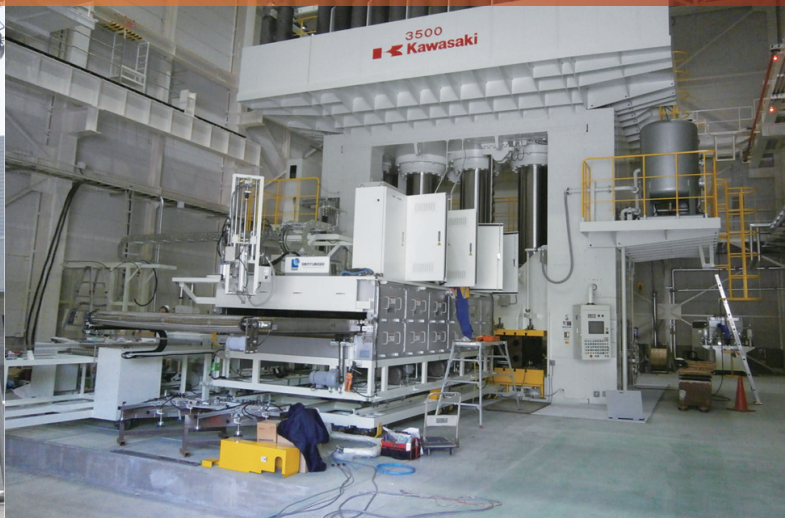
大型高速油圧プレス機（荷重容量：3,500トン）
