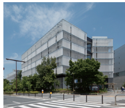
図2 ナショナル・イノベーション・コンプレックスの外観
